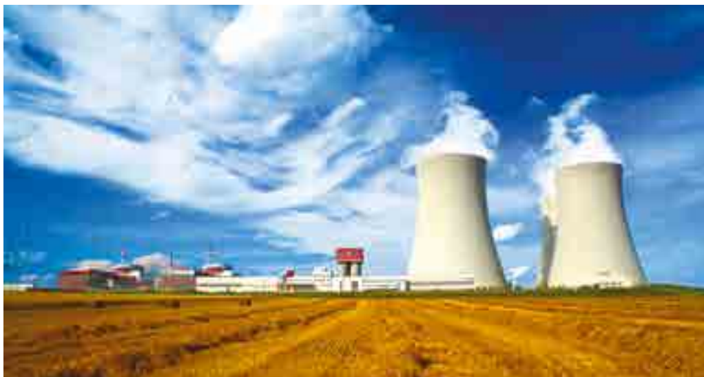
Мал. 31.3. Атомна електростанція на модульних реакторах
