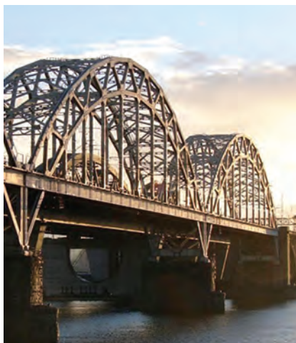
Дарницький міст через р. Дніпро
